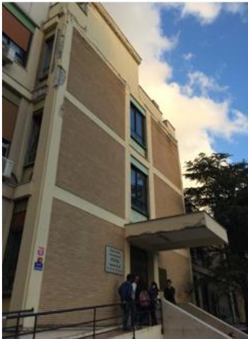
Ingresso zona aule studenti e sala lettura
